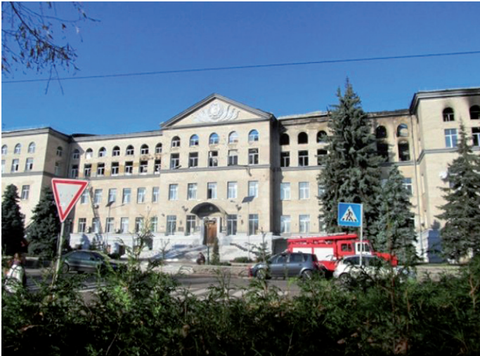
Рис. 3.16. Фасад навчального корпусу № 3. Фото 2014 р.
