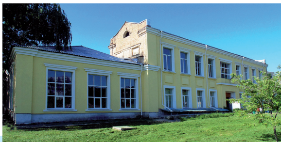
Рис. 2.36. Фасад навчального корпусу № 5. Фото 2014 р.
