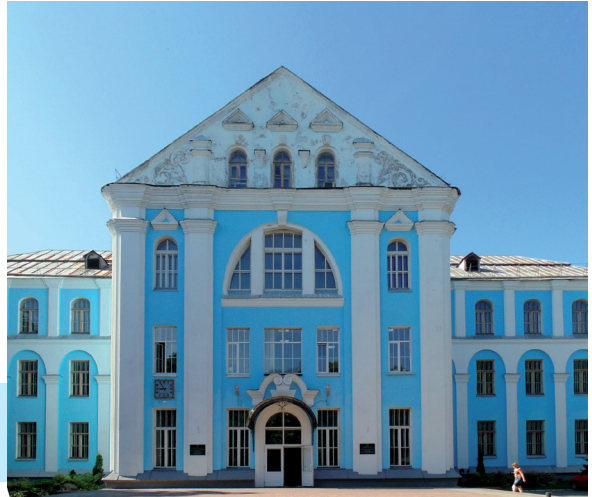
Рис. 2.24. Центральний ризаліт головного фасаду навчального корпусу № 4. Фото 2014 р.
