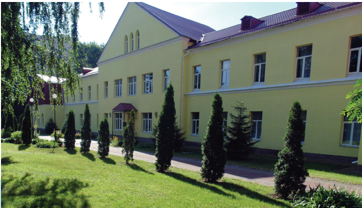
Рис. 2.30. Фасад навчального корпусу № 6. Фото 2014 р.
