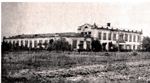
Рис. 1.30. Будівля навчально-технічної майстерні з ремонту сільськогосподарських машин КСПІ (нині – навчальний корпус № 5). Фото другої половини ХХ ст. [28]
