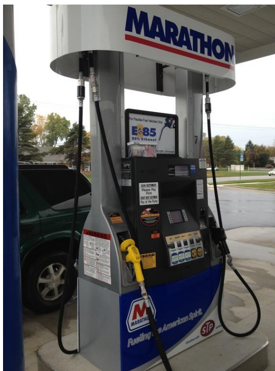
Рис. 5.1. Паливна колонка в Іст-Лансінг, штат Мічиган для продажу сумішевого палива марок Е10, Е15, Е30 і Е85.
